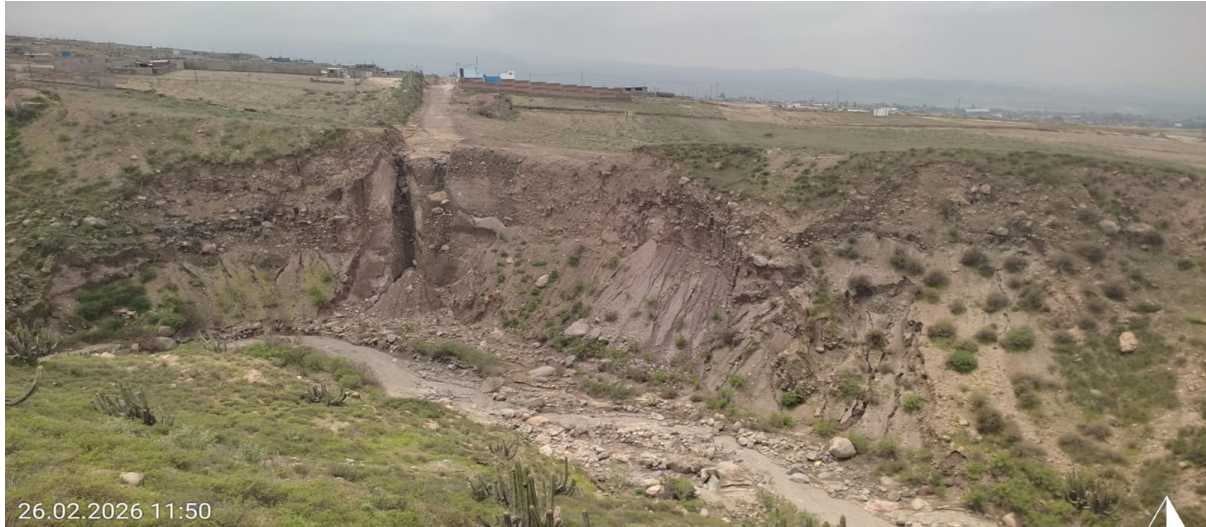
IMAGEN 01: SE MUESTRA LA COLMATACION D ELA QUEBRADA GAMARRA DONDE SE PROPONE CONSTRUIR 01 DIQUE TRANSVERSAL PARA MITIGAR LA INUNDACION AGUAS ABAJO
